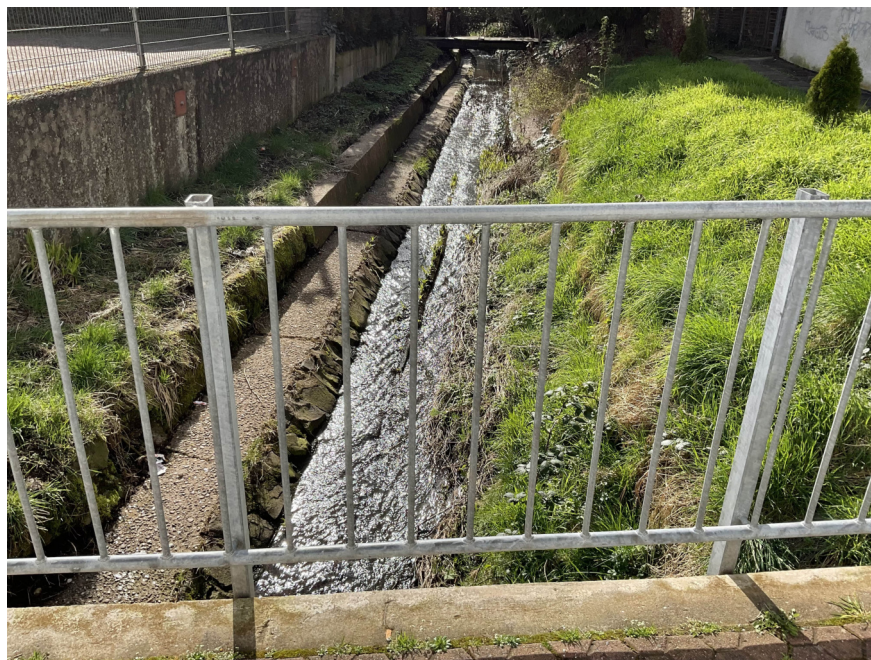
Abbildung 5: Lauterbach vor Eintritt in die Verrohrung unterhalb des Gehweges
