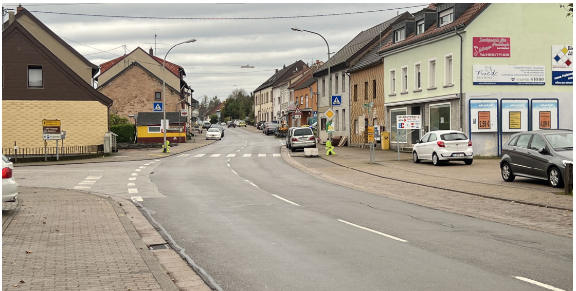
Abb. 4: Knotenpunkt L165 Hauptstraße / L277 Köhlerstraße in Richtung Carling. Von links mündet der Parkplatz des bestehenden Nahversorgers in den Knotenpunktbereich.
