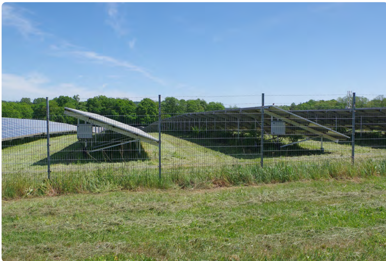
Freiflächen-Photovoltaik-Anlage beim Linslerhof
