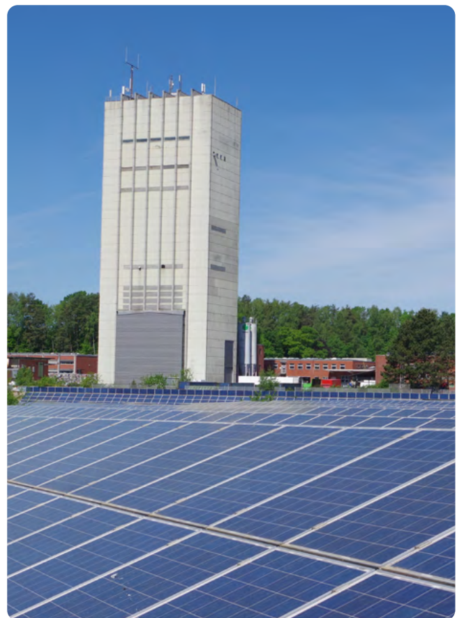
Solaranlage am ehemaligen Bergwerk Warndt
